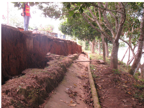
EL AGRIETAMIENTO Y HUNDIMIENTO DEL TALUD DE LA ORILLA DEL RIO EN EL SECTOR DE LA CALLE 5 ENTRE CARRERAS 29 Y 30 DEL BARRIO 20 DE JULIO
