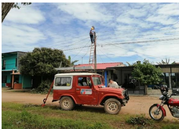
Registro fotográfico mantenimiento al sistema de alumbrado público, cambio de luminarias y podas, tomada en noviembre de 2021.
