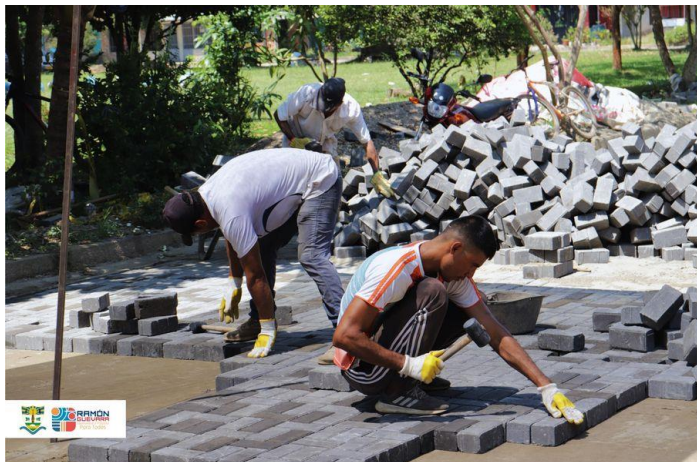
Registro fotográfico pavimento articulado, Instalación del adoquín y elementos de confinamiento, sector SENA Modelo, octubre 2023.
