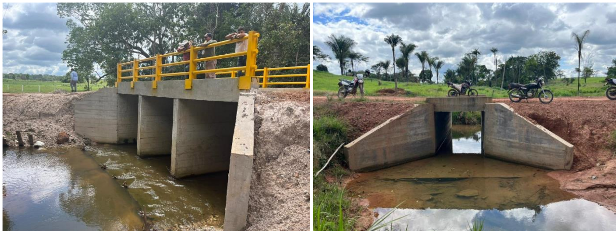
Registro fotográfico panorámica obra proyecto mejoramiento vial puntos críticos, Box sencillo y Box triple, vereda Los Alpes, enero de 2023.
