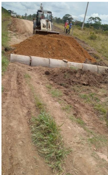
Registro fotográfico mantenimiento vial rural, construcción de alcantarilla sector Boquerón, Tomada en enero de 2021.
