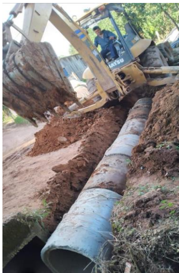
Registro fotográfico mantenimiento vial rural, construcción de alcantarilla sector Arazá, Tomada en agosto de 2020.
