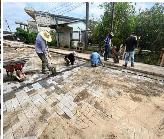
Registro fotográfico pavimento articulado, Instalación del adoquín y elementos de confinamiento, sector SENA Modelo, octubre 2023.
