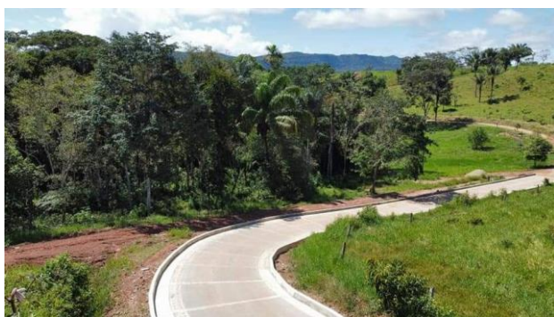
Registro fotográfico panorámica obra proyecto mejoramiento vial puntos críticos, placa huellas, vereda Los Alpes, enero de 2023.
