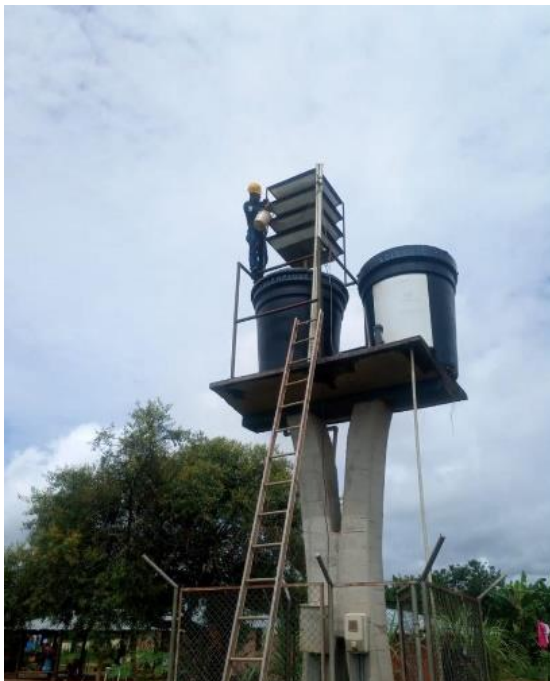
Imagen del mantenimiento y limpieza a las bandejas de aireación de una Utap, Tomada en el RI Barrancón, en diciembre de 2021, fuente Propia
