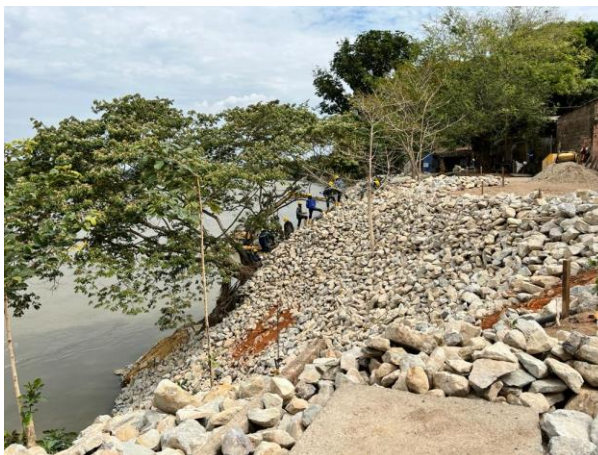
Imagen. Registro fotográfico enrocado sector Centro y 20 de julio, tomada en enero de 2022 (Fuente propia).
