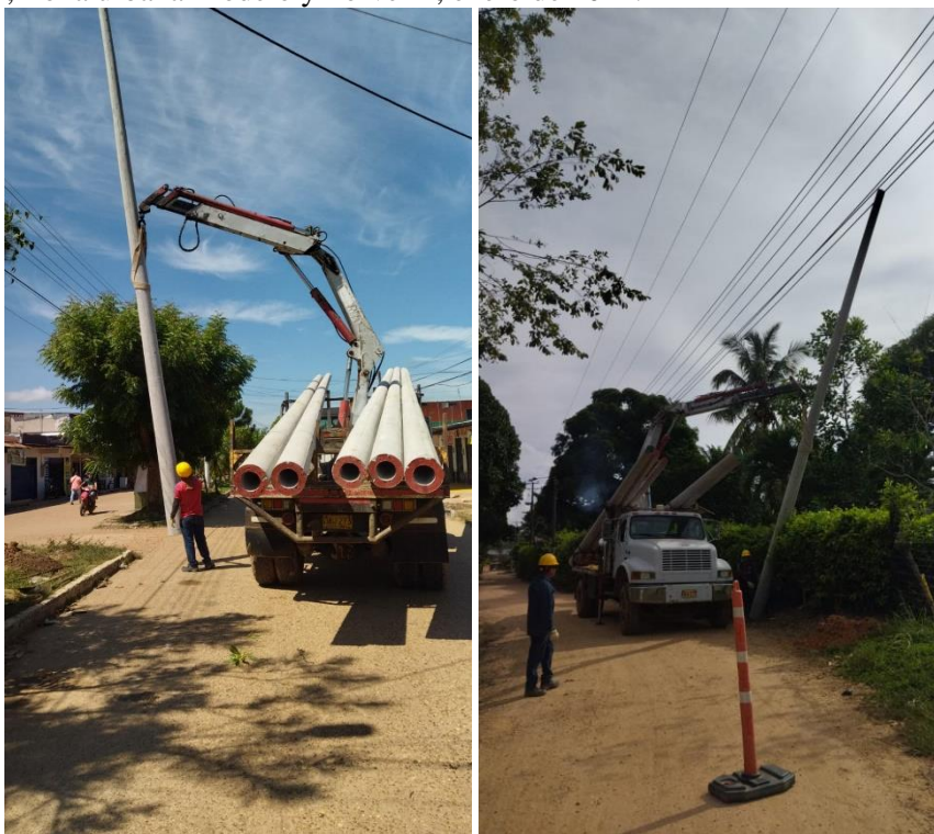
Registro fotográfico Instalación de postes del proyecto de modernización del sistema de alumbrado público, etapa 3, Zona urbana Modelo y Porvenir, septiembre de 2023.
