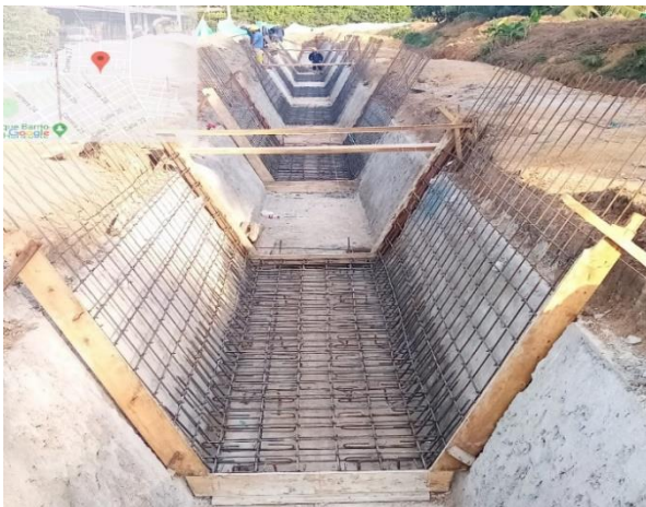
Fotografías tomadas durante la construcción y terminación de los canales de aguas lluvias, Zona Urbana Barrio Dorado y la Paz, noviembre de 2020. (Fuente propia)
