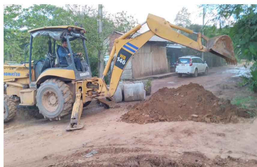
Registro fotográfico mantenimiento vial rural, construcción de alcantarilla sector Arazá, Tomada en agosto de 2020.
