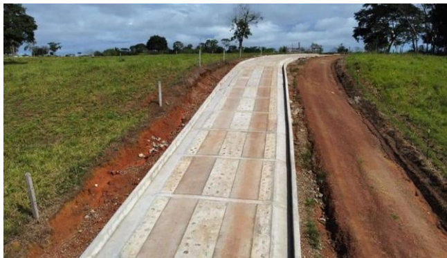
Registro fotográfico visita de obra proyecto mejoramiento vial puntos críticos, placa huella y Box culvert triple, vereda Los Alpes, enero de 2023.
