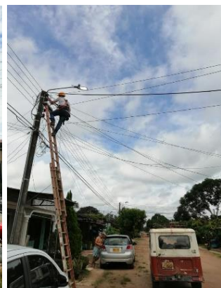
Registro fotográfico mantenimiento al sistema de alumbrado público, cambio de luminarias y podas, tomada en noviembre de 2021.
