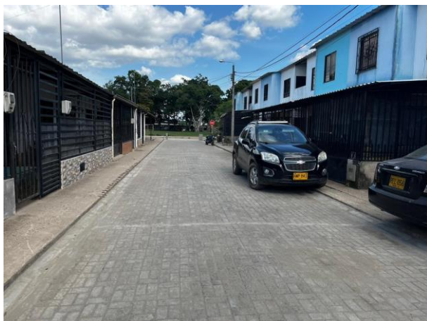
Registro fotográfico pavimento articulado, Nivel terminado sector Prados y Belén de la Paz, octubre 2022.
