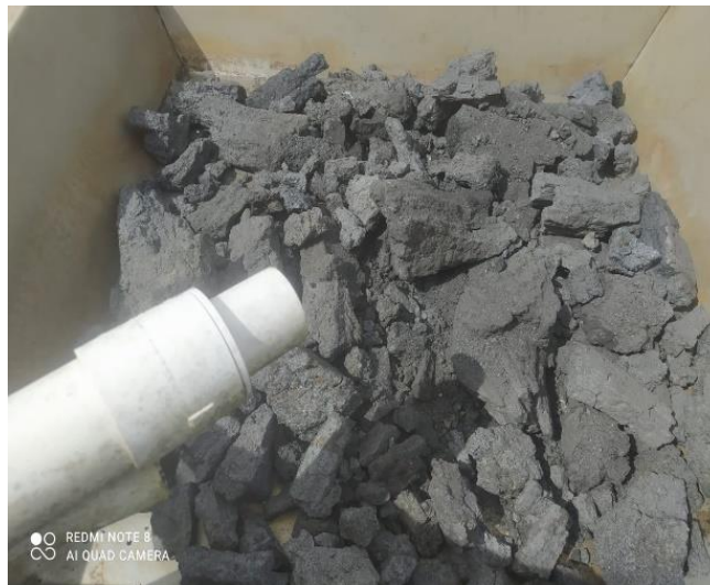
Imagen del antes y después de una bandeja de aireación de una Utap, limpieza y cambio del carbón coque, Tomada en el RI Barrancón, en diciembre de 2021, fuente Propia.
