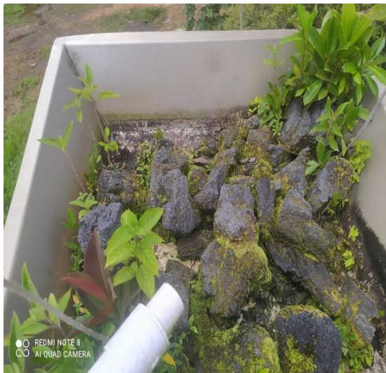
Imagen del antes y después de una bandeja de aireación de una Utap, limpieza y cambio del carbón coque, Tomada en el RI Barrancón, en diciembre de 2021, fuente Propia.
